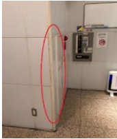
エレベーターホール左壁
